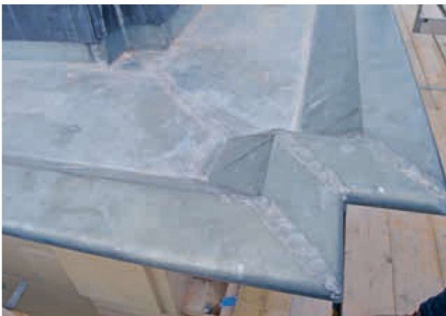
Zorgvuldig is de lasnaad met een extra laag opgedopt.
